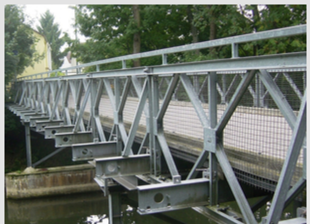
Abb. 2: Alte, beschichtete Bailey-Brücken konnte nachträglich feuerverzinkt werden.
