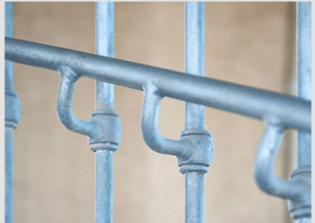
Abb. 3: Auch historische Stähle können feuerverzinkt werden.
