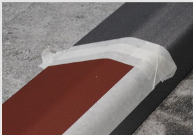
Abb 3: Durch Abkleben können hitzebeständige Farbbeschichtungen zur Vermeidung der Zinkannahme exakt appliziert werden.
