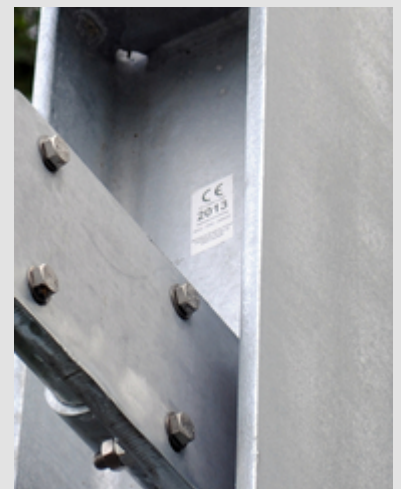
Abb. 4: Verbindungsmittel aus nichtrostendem Edelstahl in feuerverzinkter Stahlkonstruktion
